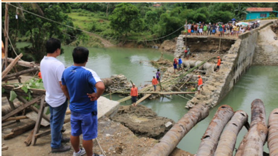
DETOUR BRIDGE HAVOC- Naglalagay ng footbridge ang mga taga-barangay Cabuluan sa bayan ng Sta. Elena habang pinag-iisipan ni Gobernador Edgardo A. Tallado ang mga kaakibat na hakbang na dapat isagawa upang sa lalong madaling panahon ay muli itong matawiran.
