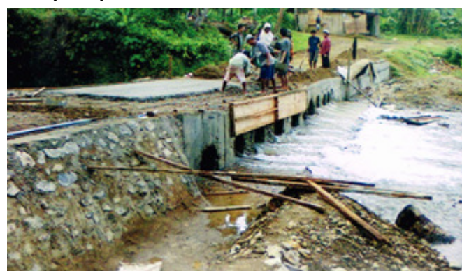
On-going construction ng Binawangan Bridge sa Capalonga
