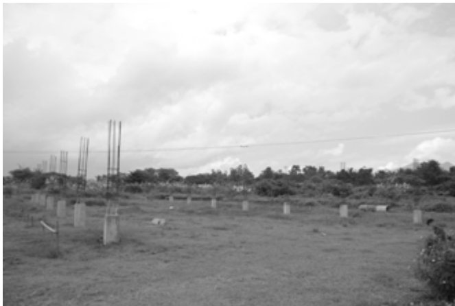
ON-GOING CONSTRUCTION ng Covered Court sa Mat-i Vinzons kung saan matatagpuan ang Sentrong Kaligtasan. Ang pasilidad na ito ay magiging lugar para sa mga pagsasanay sa DRRM
