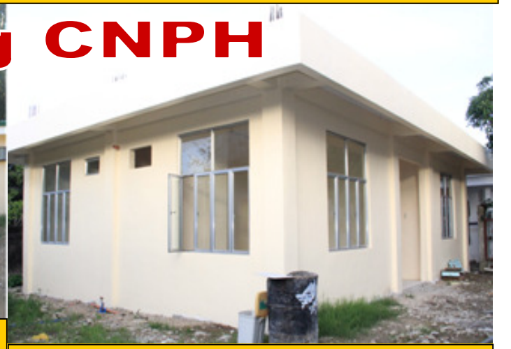
Ang bagong isolation ward; Sa ibaba ang mas malawak at mas maayos na reception area at billing section
