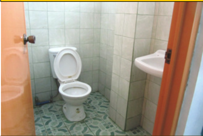
Ang konstruksyon/repair ng mga CR sa hospitals ay isinagawa din
