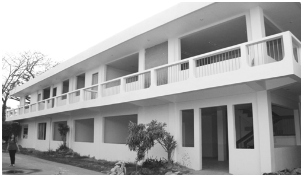
Ang bagong repair na hospital dormitory sa Camarines Norte Provincial Hospital
