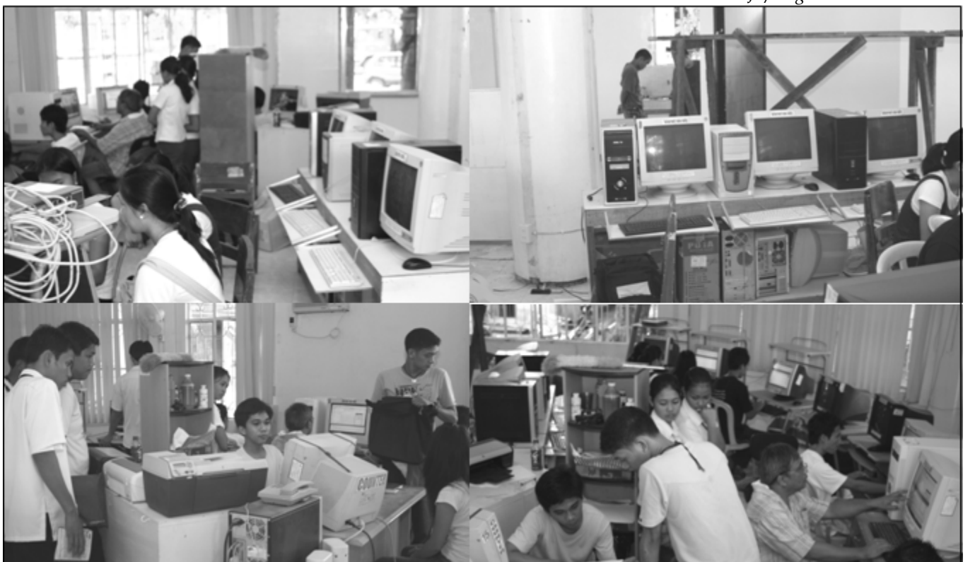
Ang Camarines Norte Community e-Center (CeC) na kasalukuyang sumasailalim sa isang renovation na isinagawa ng Provincial Engineers Office (PEO) upang mabigyang-lugar ang patuloy na dumaraming nangangailangan dito.
